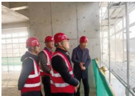
行施工作业,呈现一派繁忙的生产景象。在施工现场,寿才良董事长详细询问了工程最新进展情况,以及留嘉
